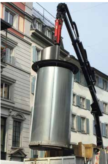
DIE KÜBEL MÜSSEN MIT EINEM KRAN GELEERT WERDEN. FOTO: TIEFBAUAMT
