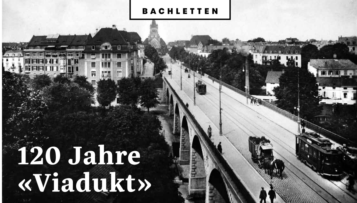
DER BLICK IN DIE VERGANGENHEIT RICHTUNG PAULUSKIRCHE: DAS VIADUKT ÜBER DEN BIRSIG IN DEN 1930ER-JAHREN (LINKS DAS ENSEMBLE «AM VIADUKT»). FOTOS: ARCHIV FRV
