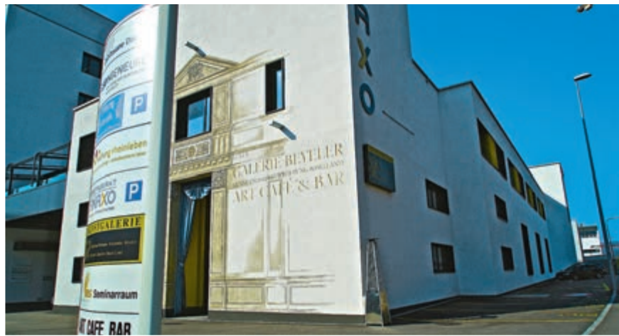
Aussenansicht der Galerie Beyeler
