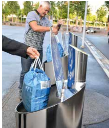
In Basel angekommen: Das System der Unterflurcontainer ist bereits an einigen Orten in Basel in Betrieb.
